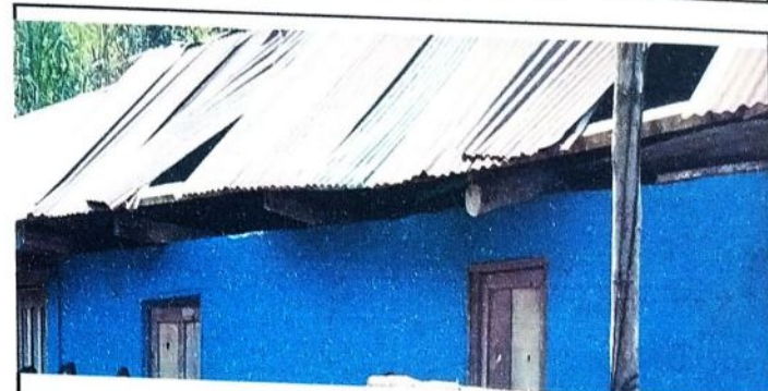
Aula No. 2: Cambio de techo de lamina troquelada, costanera, puertas y ventanas.
