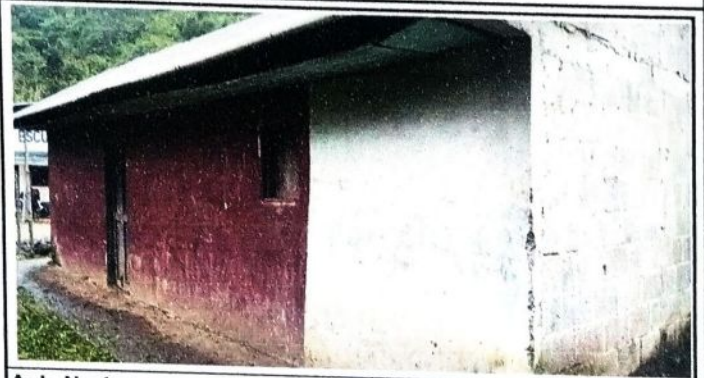
Aula No 1: Cambio de techos: 32 láminas troquelados, 12 costanera de 3x2 y 8 costanera de 3x3, Cambio de puerta: largo 1. 88, ancho 92cm, ventana 1. Largo 63cm y ancho 63cm, ventana 2. 63 largo y 63 ancho.
