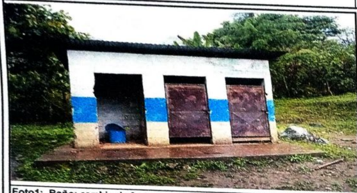
Foto1: Baño: cambio de 3 puertas: Medidas. Ancho 83cm, largo 1.47; cambio de 3 inodoros, cambio costaneras y 6 láminas troquelada de 8 pies
